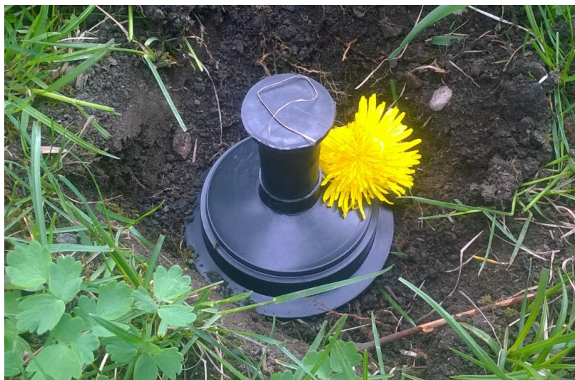
Рисунок 4 – Накопительная камера НК-32, установленная в подготовленную лунку
